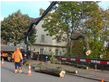
Bäume fällen Hammeralle
