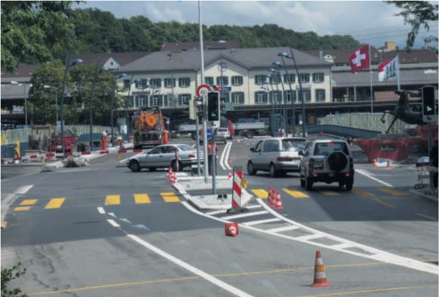
«Baustelle» Individual- und öffentlicher Verkehr
