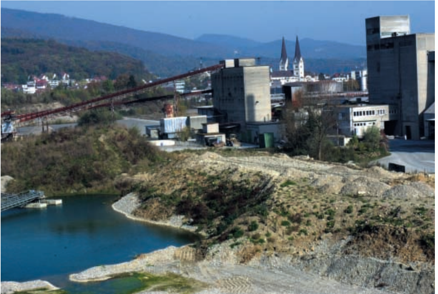
«Baustelle» Olten SüdWest
