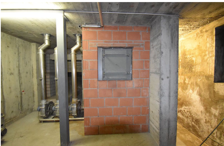
Abbildung 4: Untergeschoss mit Ofenanschluss und Luftgebläsen Ofen
