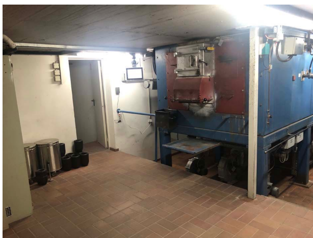
Abbildung 15: Touch Panel Untergeschoss Ofen 1 Krematorium Heidelberg
