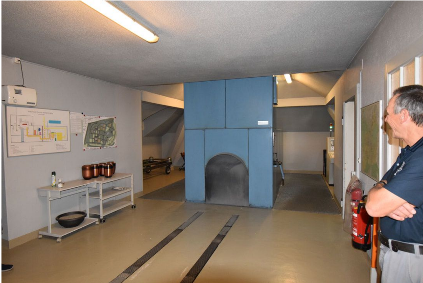
Abbildung 2: Ofenraum Erdgeschoss mit bestehendem Elektro-Kremationsofen
