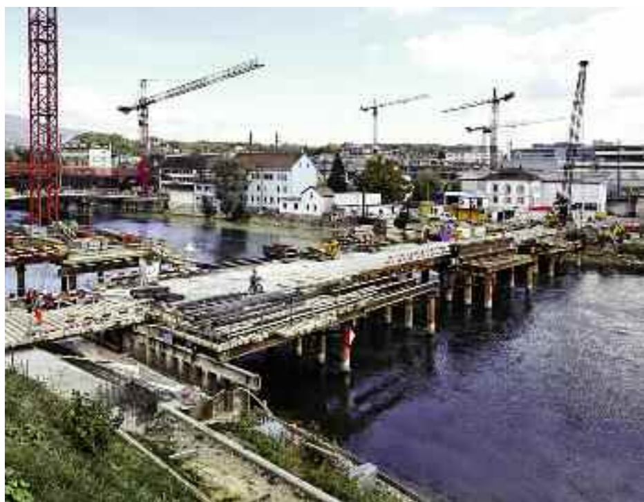
Das bisher teuerste Strassenprojekt im Kanton Solothurn: Entlastung Region Olten
