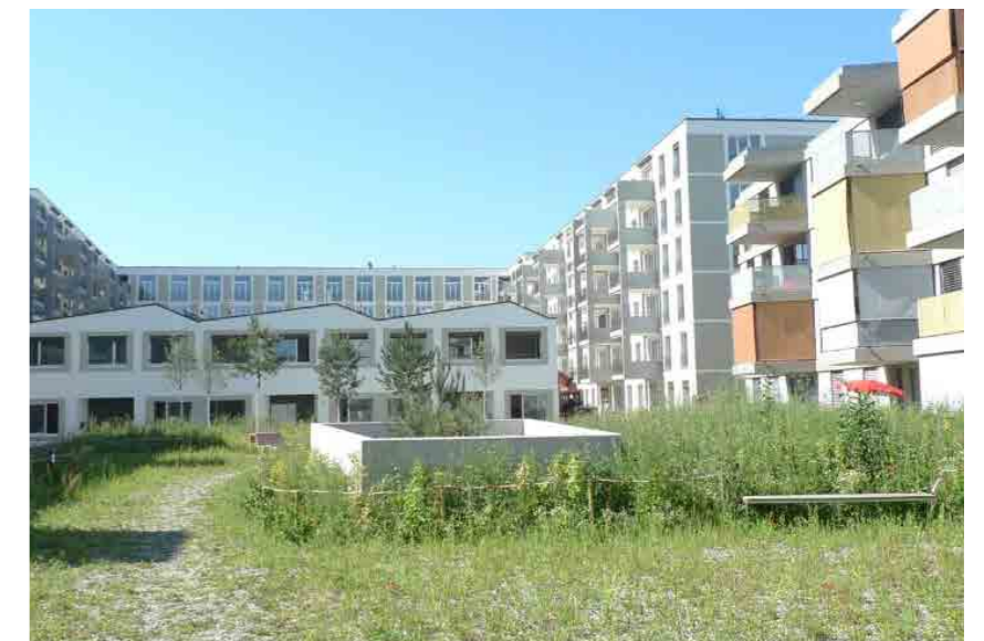
Referenzbild: Überbauung Erlenmatt West, Basel Quelle: http://www.stadtwohnen.bs.ch/wohnbauprojekte/aktuelle-projekte.html , Stand August 2017
