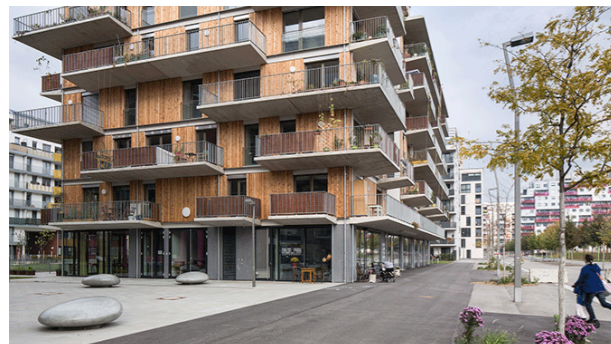
Referenzbild: Wohnhaus «Wohnprojekt Wien» Quelle: https://www.architektur-aktuell.at/news/staatspreis-architektur-und-nachhaltigkeit-2014 , Stand August 2017
