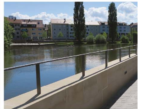
Sockelmauer mit Handlauf
