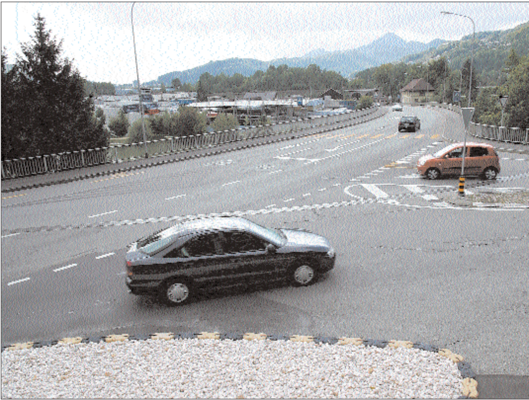
RANKWOOGBRÜCKE Sie wird im Jahr 2011 vom Kanton total saniert und bleibt dann voraussichtlich ein halbes Jahr lang für den Verkehr gesperrt. HR. AESCHBACHER
