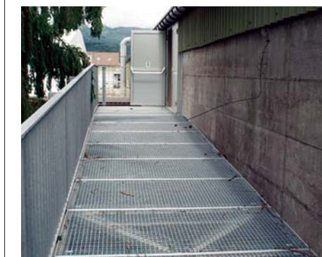
Im Bereich der Sitzplatztribüne West wurde ein zusätzlicher Entfluchtungsangang realisiert.
