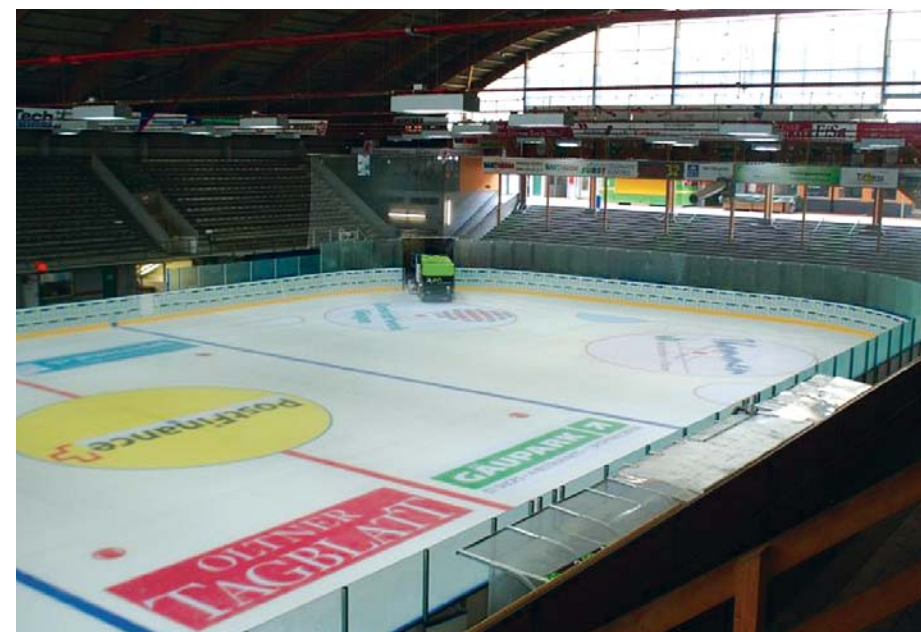
Bereits saniert: die gesamte Bandenanlage...
